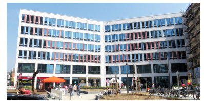
Tag der offenen Tür im neuen Technischen Rathaus
