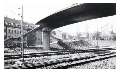
Fußgängerbrücke Hainstraße 1965 im Bau
